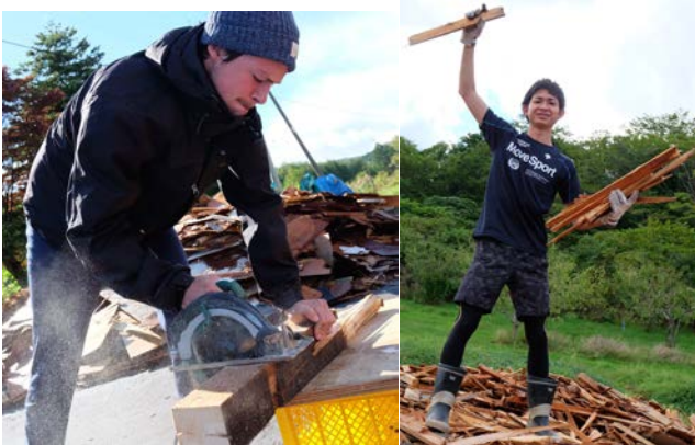
解体した住宅の廃材を片付ける外国人ボランティアと学生
